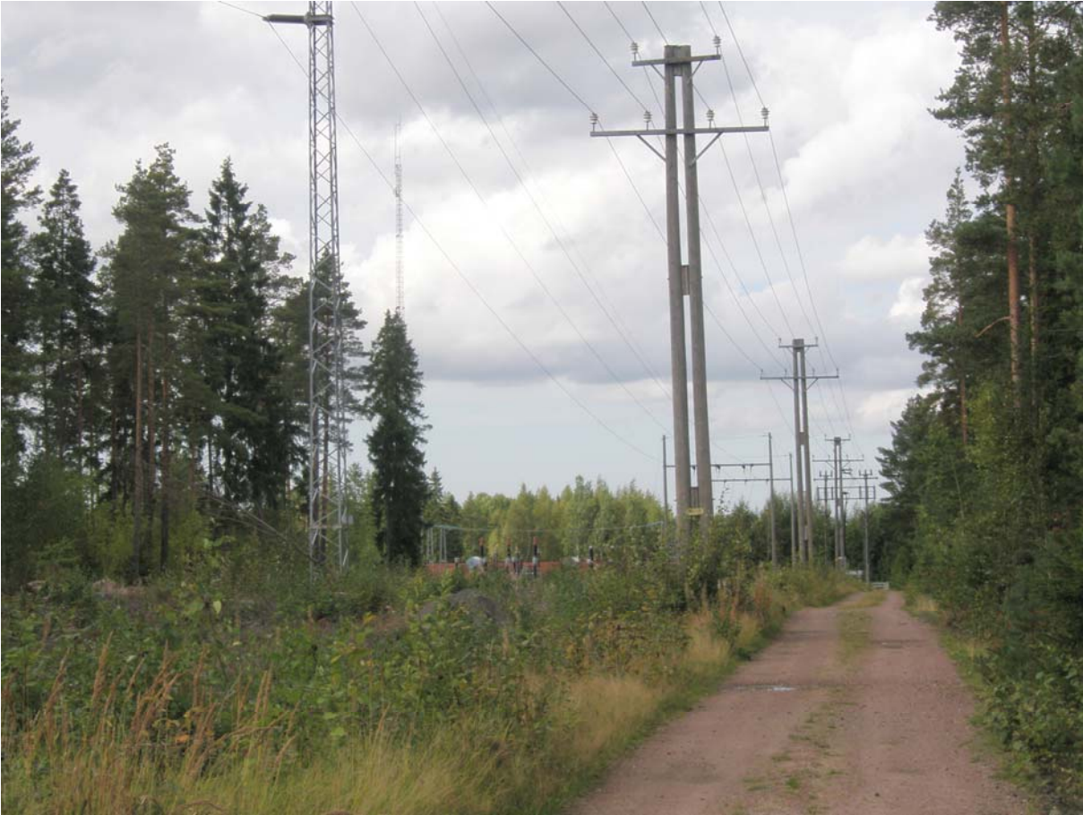
Kuva 3: Lähivirkistysalueen sähkölinjat ja ajoyhteys muuntoasemalle.
